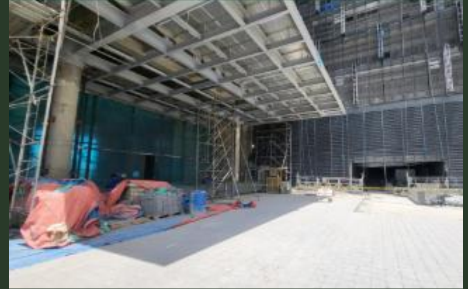
Parklinks North Tower Motorcourt – Actual Photo
